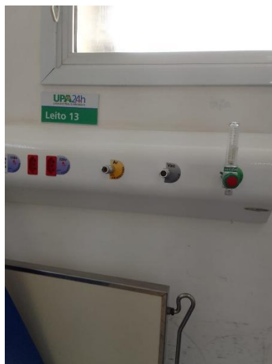
01/04 – Substituição fluxometro leito 13 observação infantil
